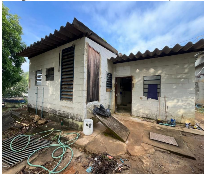
Figura 5. Infraestrutura do laboratório e casa de química
