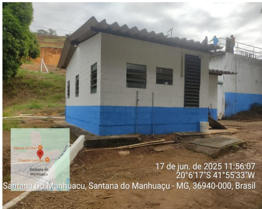
Figura 11 – Sede Administrativa e atendimento comercial
