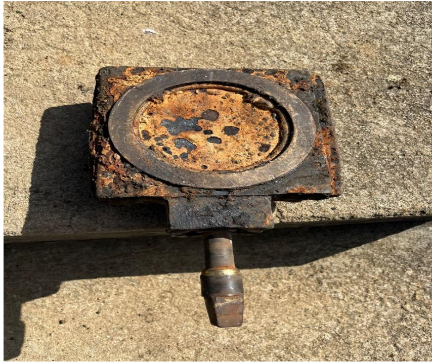
Figura 6. Troca da comporta do Registro dos filtros
