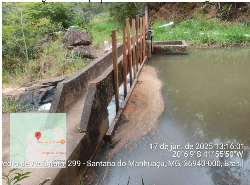
Figura 16 – Captação Ribeirão Santana - Barragem
