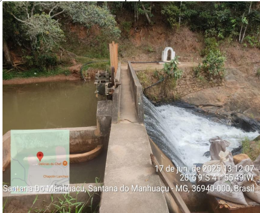
Figura 19. Barramento atual na captação do SAAE no Ribeirão Santana.
