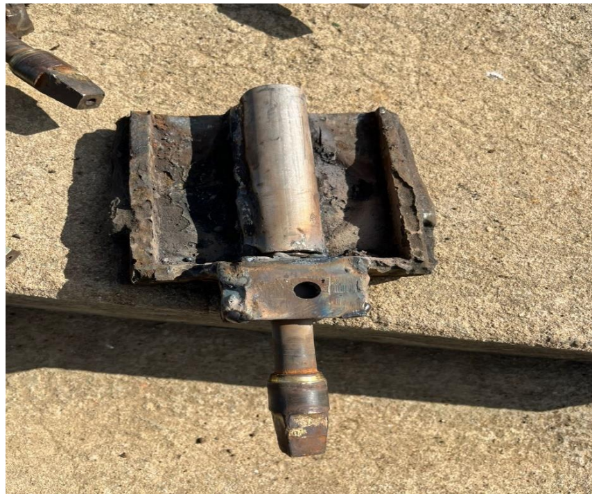
Figura 7. Manutenção no sistema de filtração da ETA
