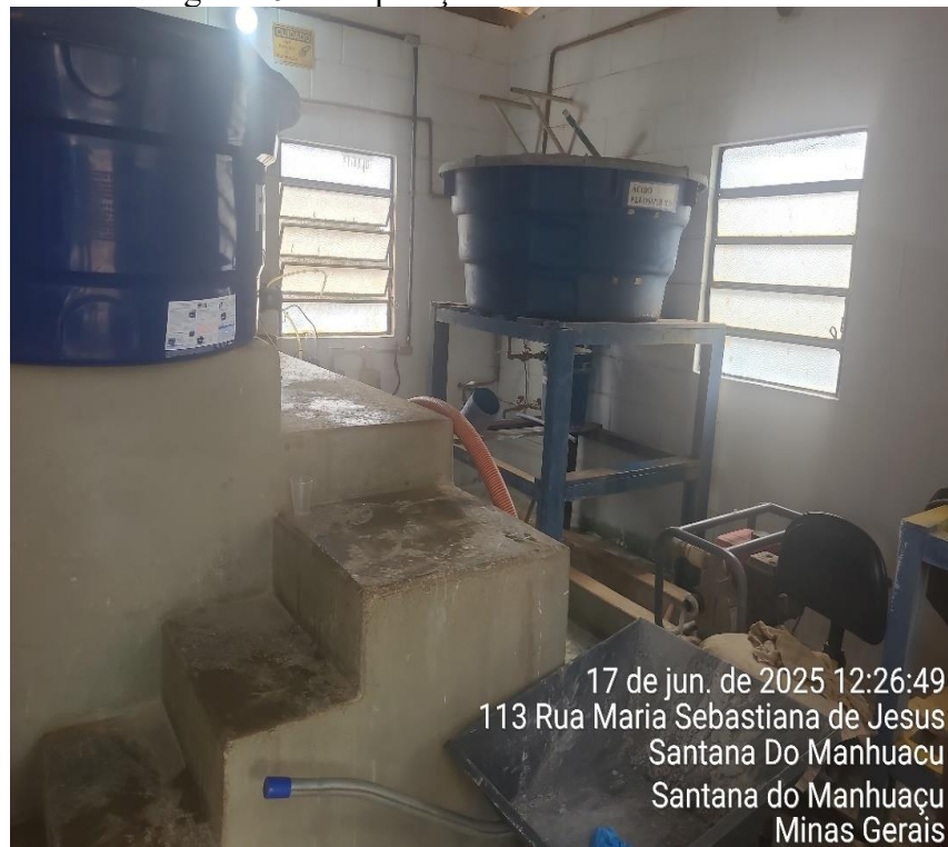
Figura 29 – Preparação do hidróxido de sódio
