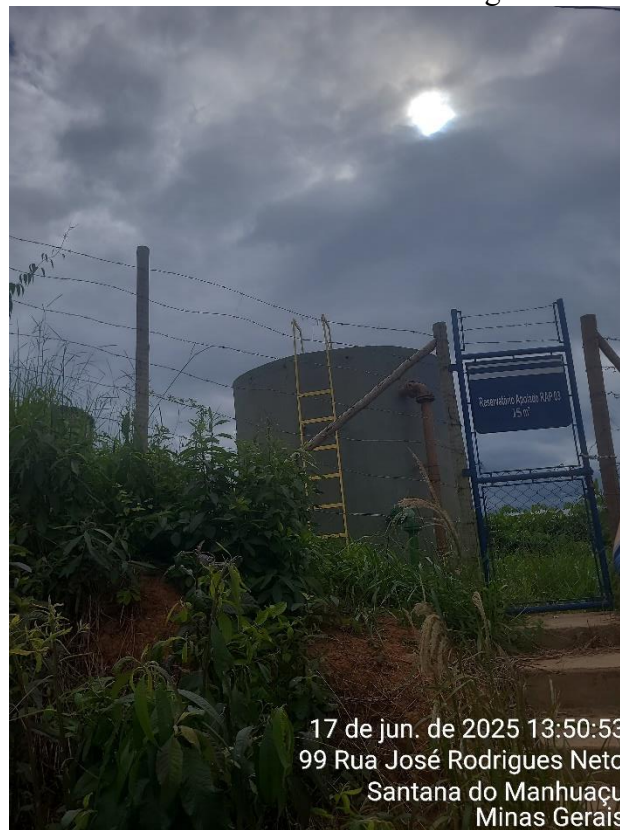
Figura 42 – Reservatório da rua José Rodrigues Neto 15 m 3 .
